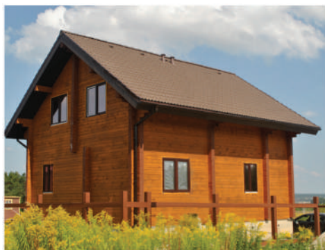
Деревянный дом, Московская область. Обработан составами серии «Pirilax», «Krasula» для наружных и внутренних работ.
