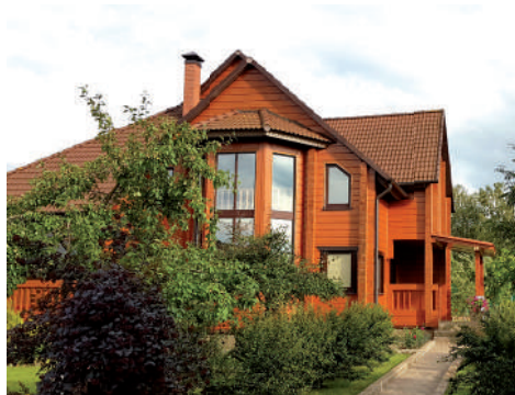
Деревянный дом, Московская область. Обработан «Pirilax»-Classic, «Krasula» для наружных и внутренних работ ООО «ТД Пожзащита».
